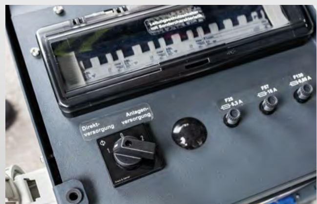
Umschalter Direktversorgung-Anlagenversorgung.
